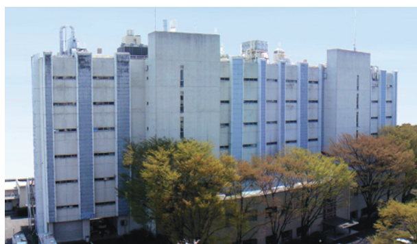
写真2 愛知衛生研究所全景
