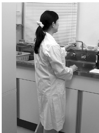
写真9 通常より10cm高く設置されている蛇口
