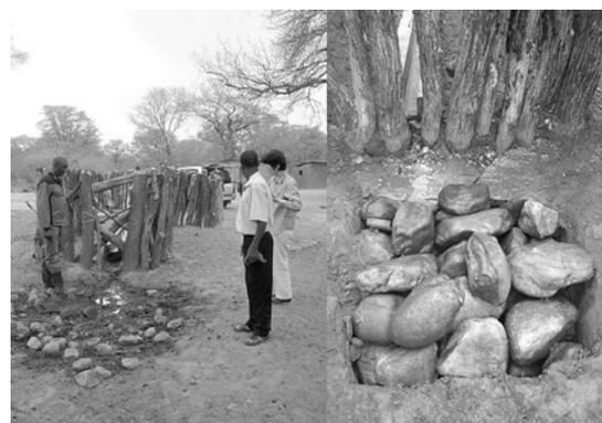
写真16 蚊の発生を抑えるため、井戸水の出口の水たまりには穴を掘り石を埋めることが重要
