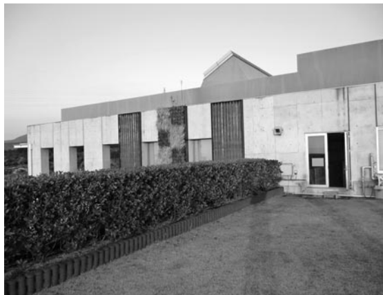
写真9 センター外壁と屋上の緑化
