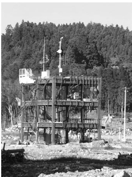
写真2 南三陸町防災対策庁舎 （宮城県 南三陸町）
