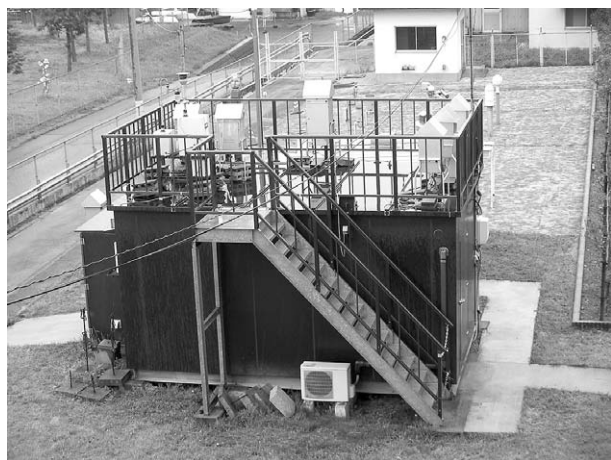
写真13 敷地内にある国設松江大気環境測定所。 その裏側にライダーがあり、レーザー光を上空に 向けて発射し、浮遊微粒子からの反射光を測定する。
