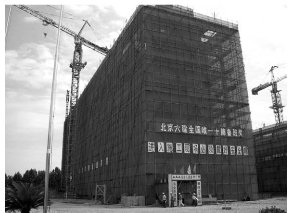
写真 1 建築中の微生物研究所
