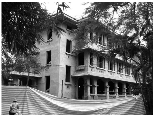
写真 5 NIHE ハイテクセンタービル建設風景
