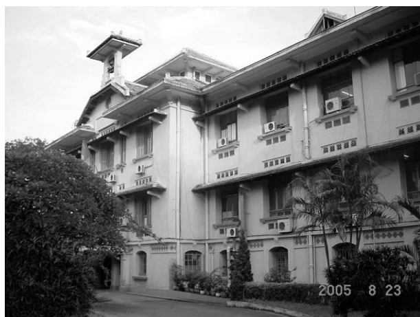
写真1 ベトナム国立衛生疫学研究所 (NIHE) 中央研究棟前景
