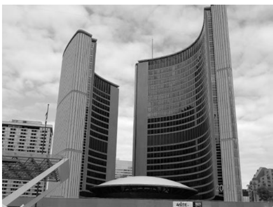
写真13 トロント市庁舎
