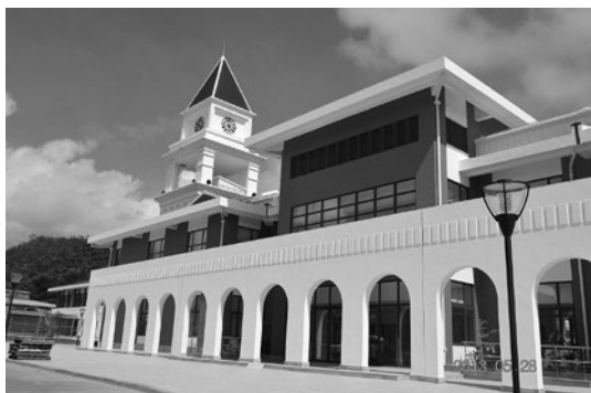
写真5 新築中のサモア医科大学附属病院
