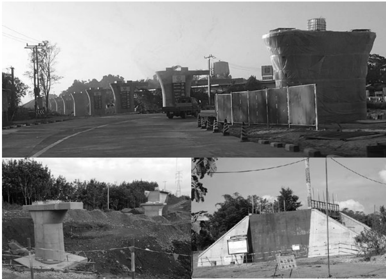
写真2 中国とラオスを結ぶ高速鉄道の建設現場
