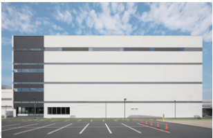
野木工場 IPCC棟
