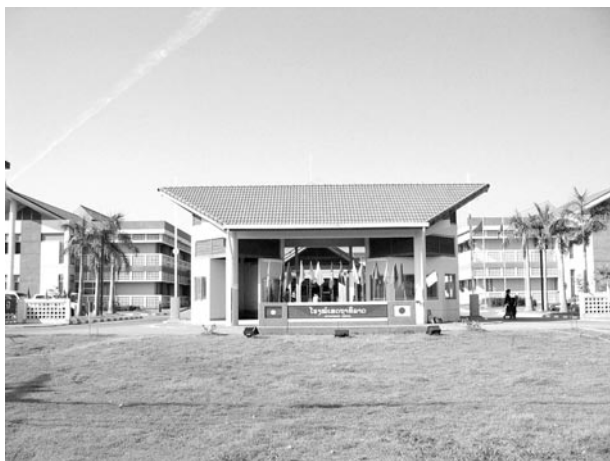
写真8 新セタティラート病院
